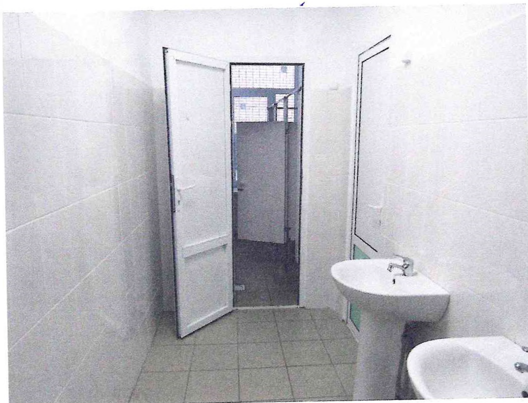
Санитарная комната на 2 этаже
